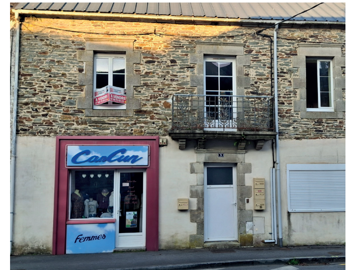
Façades avec pierres destinées à être recouvertes par un enduit
