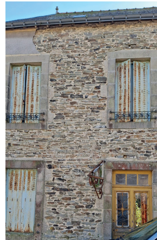
Façades avec pierres destinées à être recouvertes par un enduit
