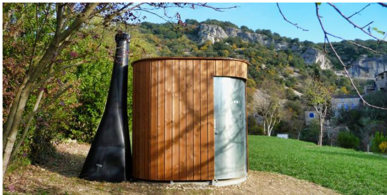
Toilettes sèches (source « Kazuba »)
